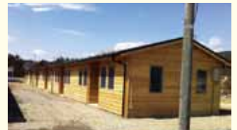
建設中の女川町の仮設店舗街(3月21日 現在の様子)
